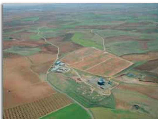
▶ Foto aérea E.T. y relleno sanitario sellado de Valdepeñas
