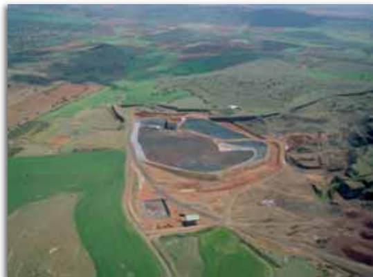
▶ Foto aérea nuevo vaso vertido de Almagro
